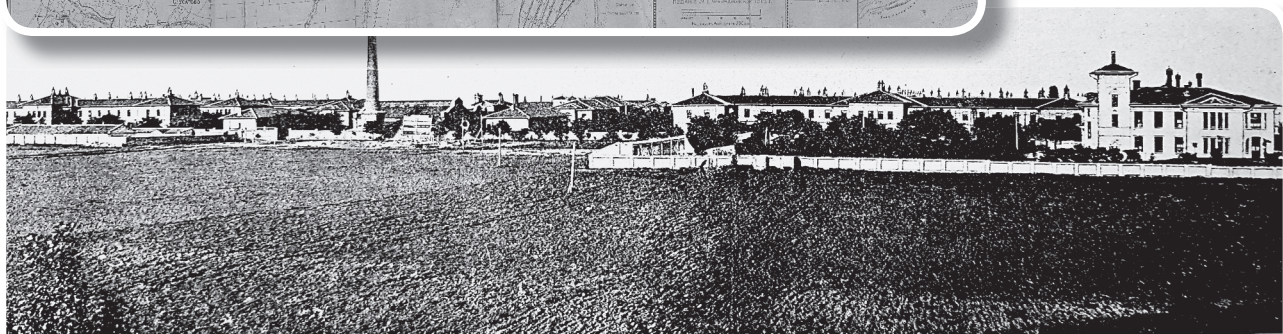
II корпус Цейхгауз Машинное здание Деструктор Интернат сестер I корпус Панкєєвское отделение
